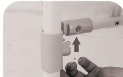
Наденьте на ножки фиксаторы распорок и закрепите распорки, установленные на сиденье стульчика.
